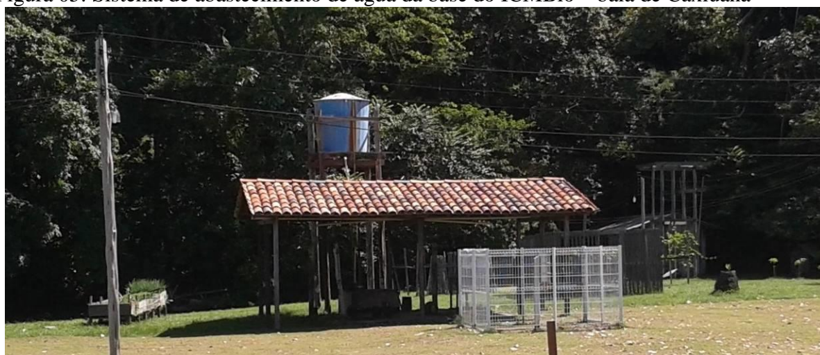
Figura 05: Sistema de abastecimento de água da base do ICMBio – baía de Caxiuanã
