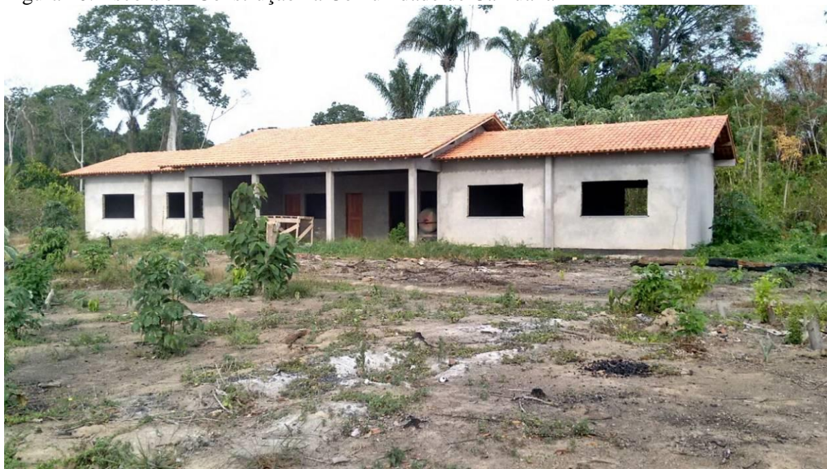
Figura 10: Escola em Construção na Comunidade de Caxiuanã
