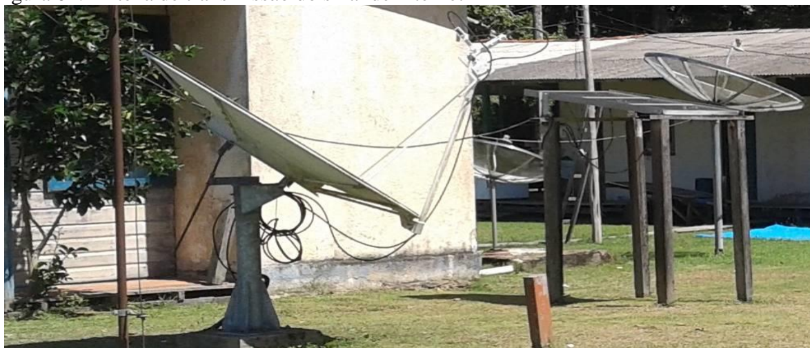
Figura 04: Antena de transmissão do sinal de internet
