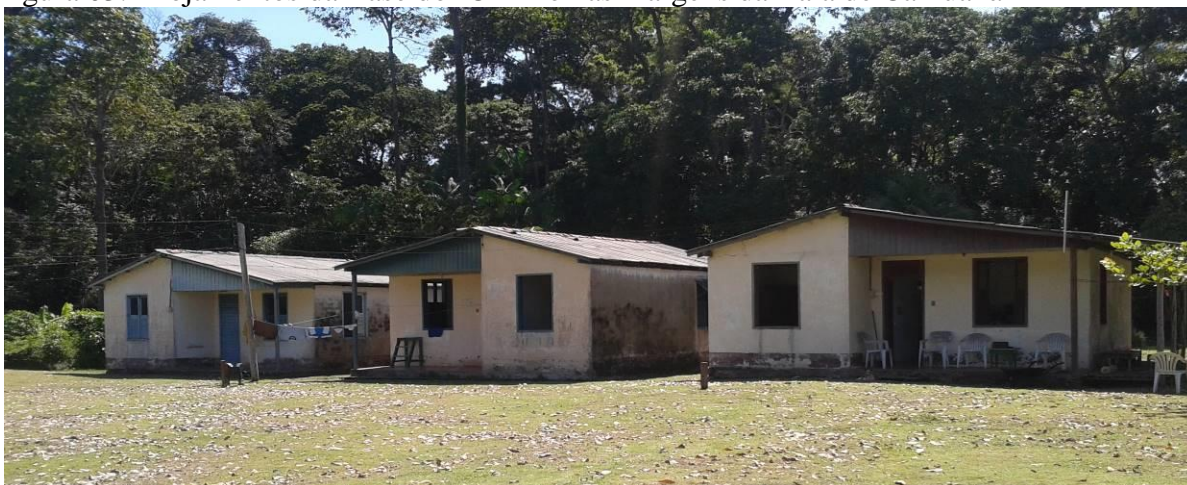
Figura 03: Alojamentos da Base do ICMBio nas margens da Baía de Caxiuanã
